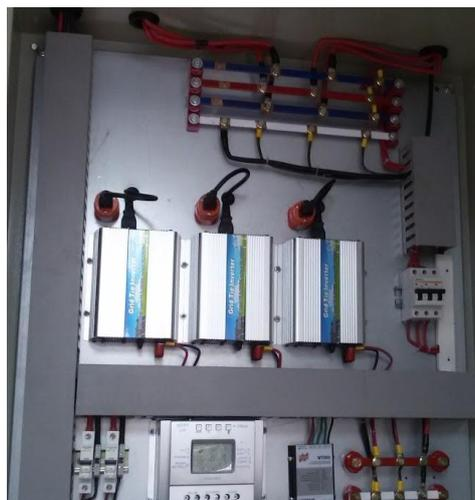
Figura 40. Montaje del tablero e instalación de los equipos.
