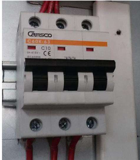
Figura 39. Interruptor Térmico-magnético de 10A.
