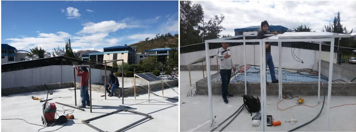
Figura 30. Construcción de la estructura y montaje de los paneles solares.
