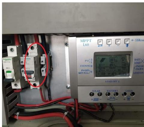
Figura 33. Interruptor Térmico-magnético de 32A.
