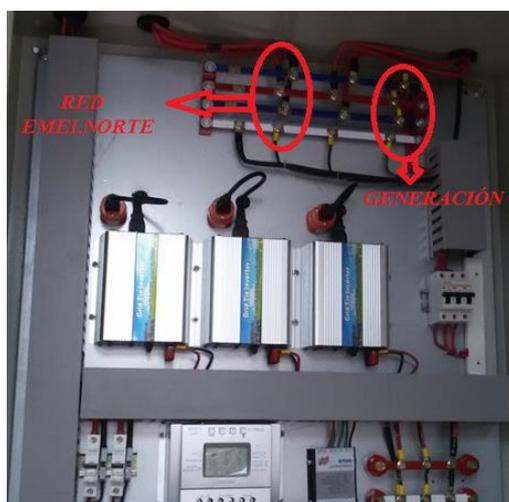
Figura 41. Conexión de generación eléctrica con la red de distribución.
