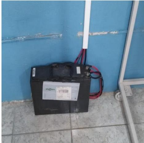
Figura 35. Instalación de la batería solar con el regulador de carga.
