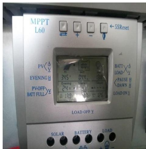
Figura 34. Instalación del regulador de carga solar.
