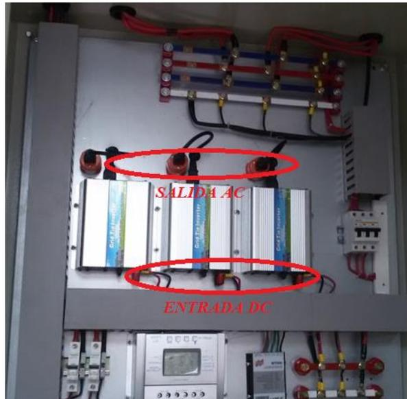
Figura 37. Instalación de los inversores.
