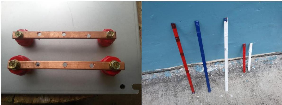
Figura 36. Instalación y pintado de Barras DC.
