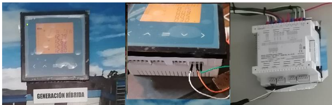
Fig. 7. Instalación del Regulador de energía reactiva MASTER control Var.
