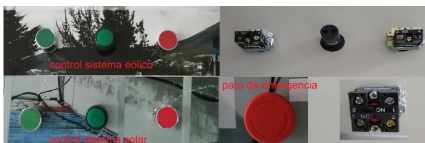
Fig. 3. Instalación de contactores, pulsadores y luces indicadoras al tablero de inversores.
