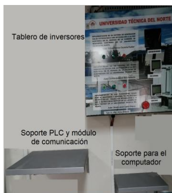
Fig. 10. Base soporte para la implementación del computador y PLC.
