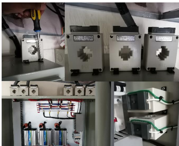
Fig. 2. Instalación de TC's en el tablero de inversores.
