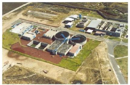
Ilustración 23: Planta de Barros (Lodos) Activados
