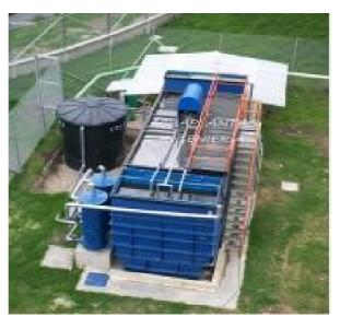
Ilustración 26: Barros activados Aireación Extendida
