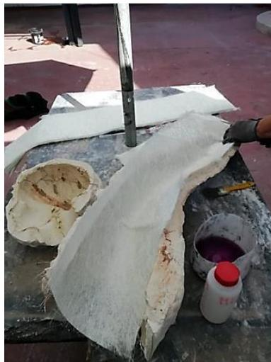
**Figura 49.** Colocación fibra de vidrio.
