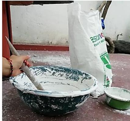
**Figura 30.** Preparación del yeso para refuerzo de la estructura.
