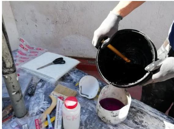
**Figura 48.** Preparación de la fibra de vidrio y dosificación de la resina.
