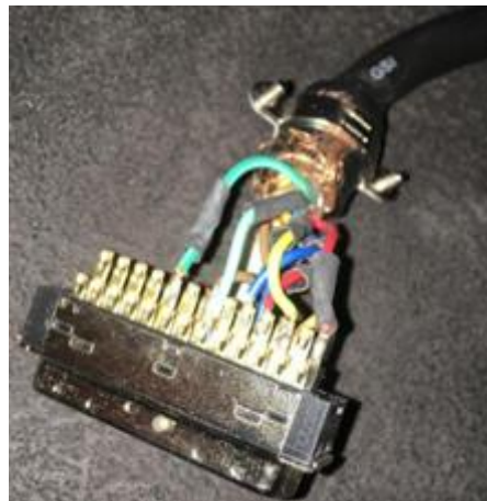
Figura 21 Cables recortados de los drivers de los servomotores.
