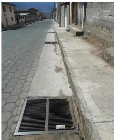
*Figura 24.* Canales de Riego subterráneos, con reja para desfogue de aguas de lluvia - Calle General Enríquez.
