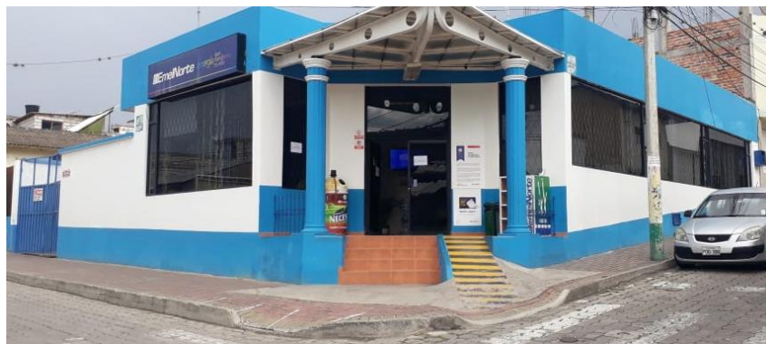
Figura 8. Empresa Eléctrica Regional del Norte EMELNORTE. S.A Agencia Pimampiro
