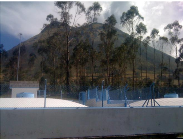
Fig 5 Tanques gemelos estación tres
