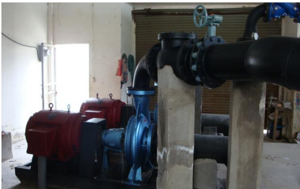
Fig 3 Grupos motor – bomba en la vertiente de Araque
