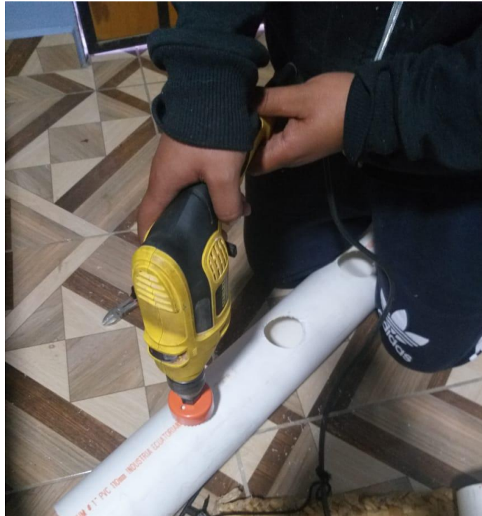
Anexo 2. perforación de tuberías para el sistema NFT.
