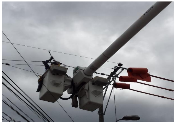
Gráfica 64. Cambio de aislador PIN
