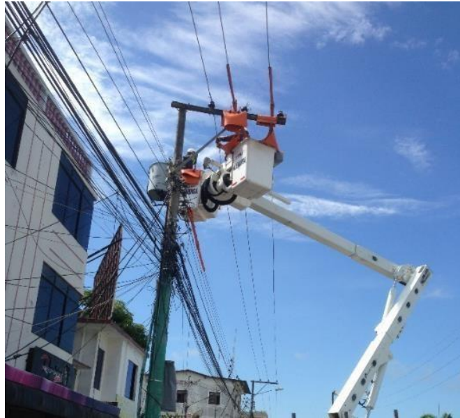
Gráfica 65. Cambio de Crucetas trifásicas sencillas
