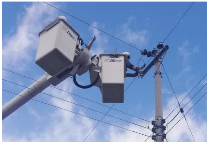
Gráfica 66. Cambio de conectores de compresión tipo “H”
