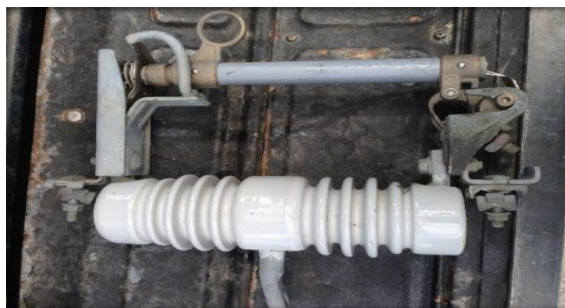
Gráfica 21. Seccionador Eléctrico
