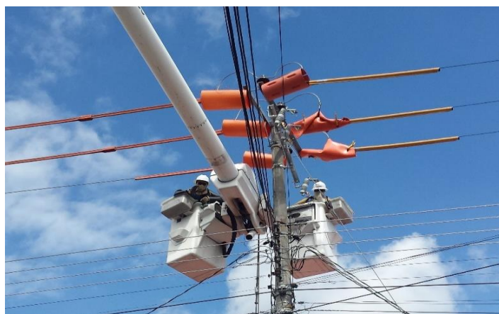
Gráfica 68. Cambio de seccionador
