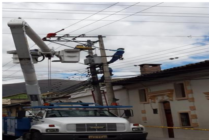
Gráfica 16. Cambio-Montaje de Transformador Trifásico
