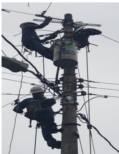
Gráfica 67. Instalación de estribos en U para transformador
