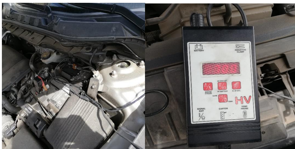
Figura 2.8 Instalación del cuentarrevoluciones
