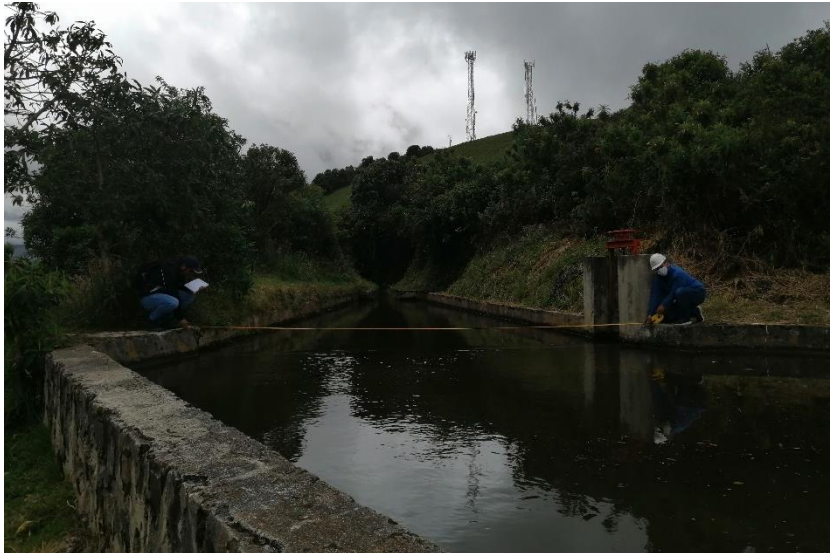
Fig. 33 Desarenador tanque de presión Fuente: Propia
