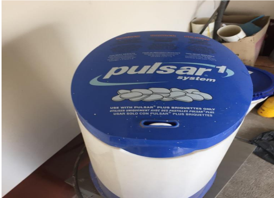
Figura 64. Equipo Pulsar System 1 de cloración de agua
