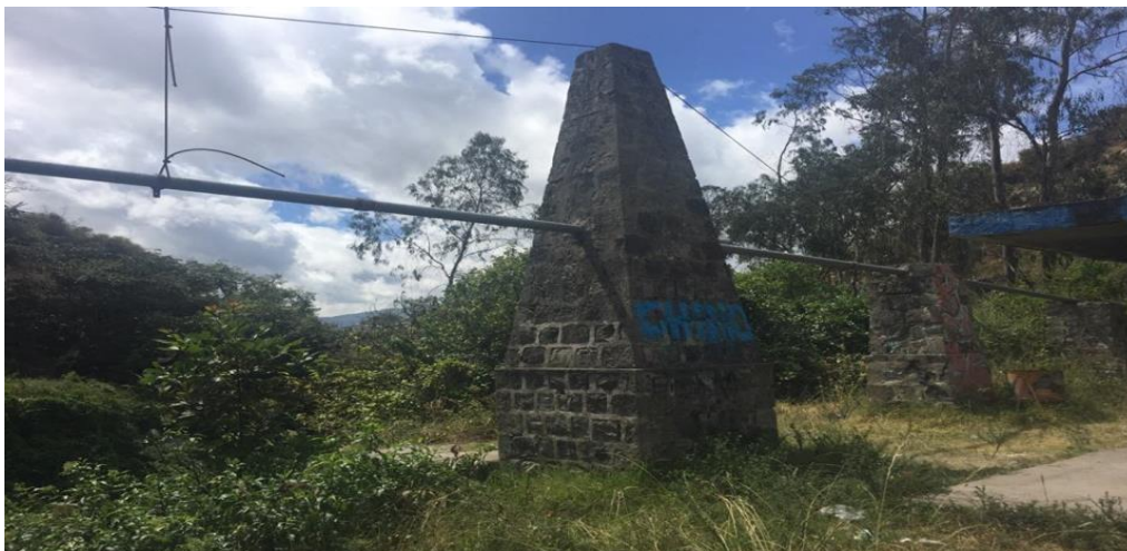
Figura 20. Tubería de Transporte
