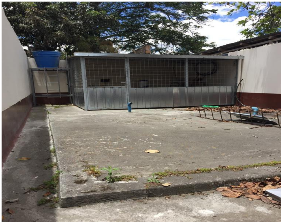
Figura 63. Estructura del tanque reservorio de agua
