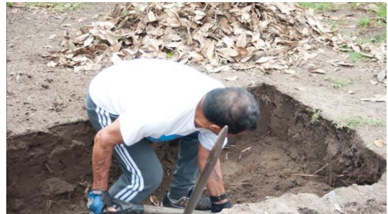
Figura 19. Construcción del horno. Fuente: Autoría propia
