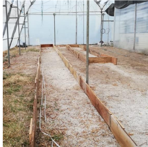
Foto 2. Construcción de platabandas en invernadero
