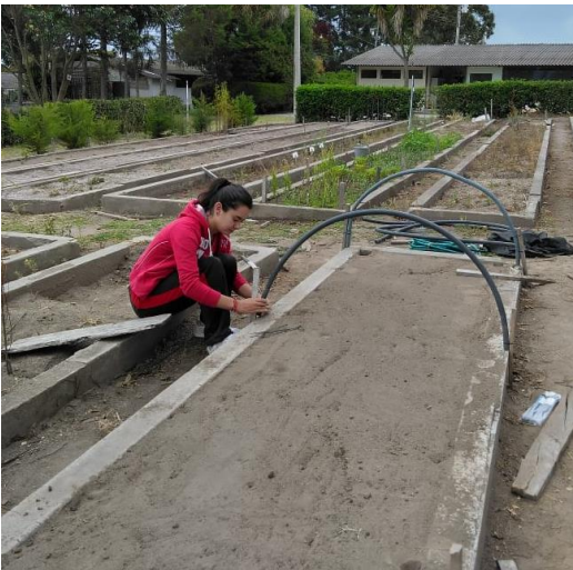
Foto 3. Armado de estructura en platabandas de vivero
