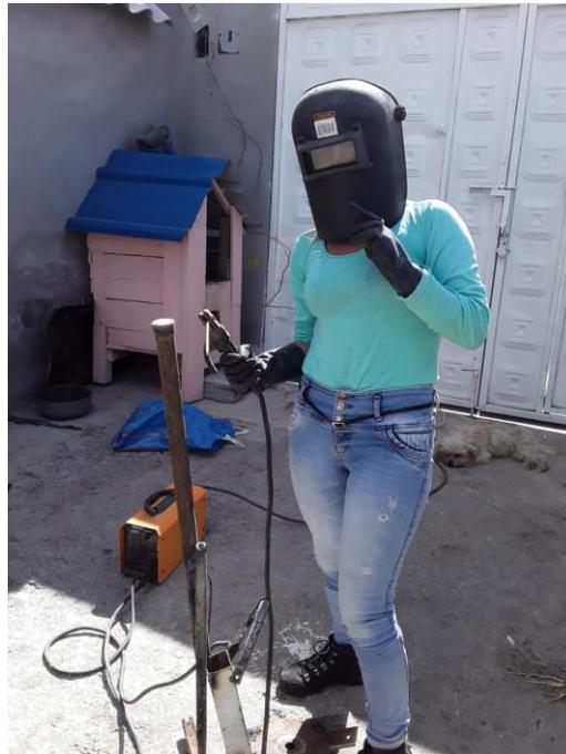
Figura 14. Suelda casco guantes, electrodos, metal, vestuario para soldar.
