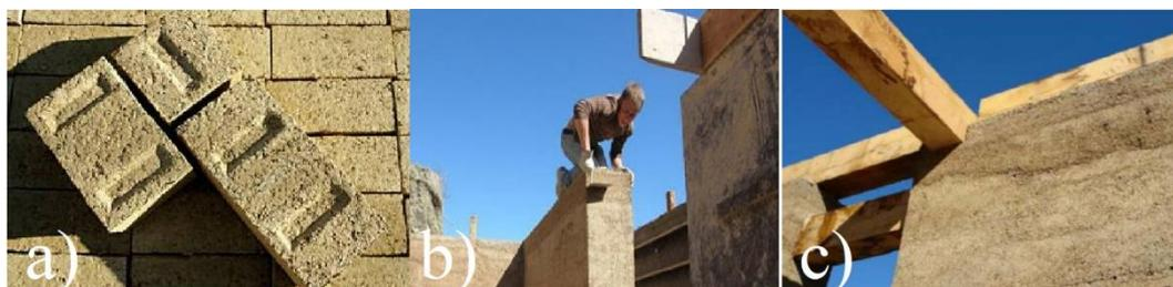
**Figura 2.** Cáñamo como material de construcción en España. a: bloques compactos, b: y c: paredes compactas de cáñamo.
