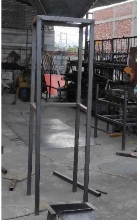
Figura 34: Construcción de la estructura
