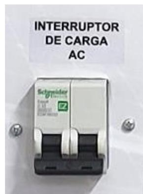
12) **Breaker de carga AC:** Sirve para conectar y desconectar las cargas en AC, además de protección de sobrevoltajes.
