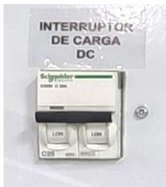
6) **Breaker de cargas DC:** Este breaker tiene la función de proteger las cargas de 12V en DC, además de conectar y desconectar toda la red DC.
