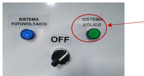
Fig. 2 Panel de selección del sistema eólico o fotovoltaico
