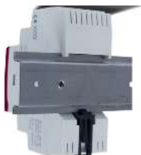
Fig. 26: Instalación de módulo de conexión IP. Fuente: (HDL, 2021)
