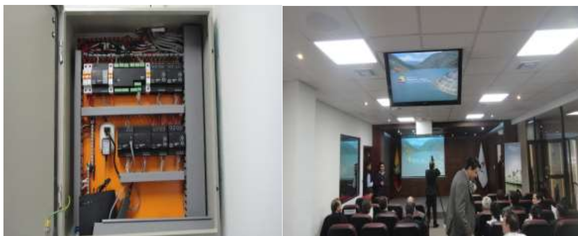
Fig. 12. Sistema inmótico sala de conferencias Arconel. Fuente: (HDL Ecuador, 2018)
