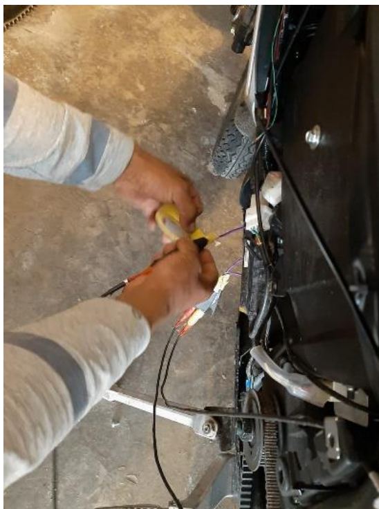
Figura AI.3. Conexiones de pinzas de tensión a las fases del motor
