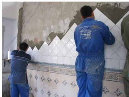
Figura 1 Revestimiento discontinuo [7].
