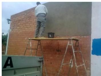
Figura 3. Revestimiento tipo revoco [21].
