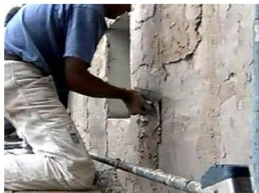
*Figura 2.* Revestimiento tipo enfoscado [20]
