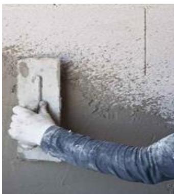
Figura 6. Tendido de Mortero [27].
