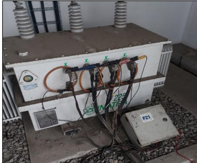
Fig. 25. Conexión de equipos en los puntos de referencia.
