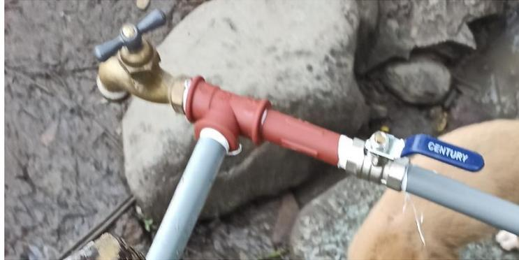
**Figura 28.** Derivación del suministro de agua
