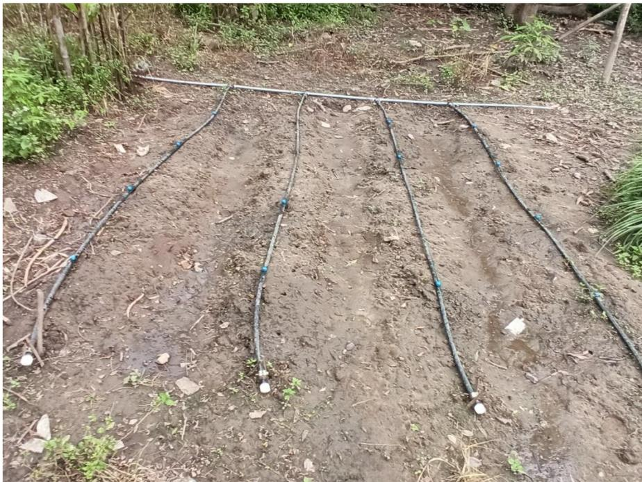
**Figura 31.** Instalación del sistema para riego por goteo
