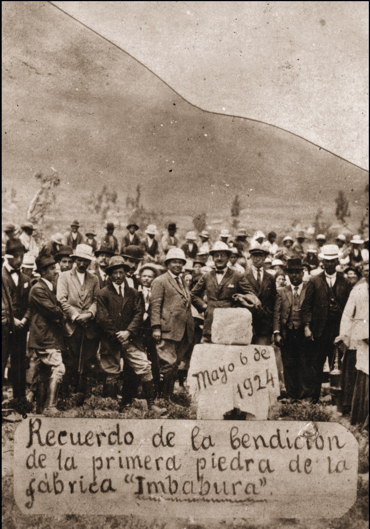
Colocación de la primera piedra de la Fábrica Imbabura, fundada por los catalanes Antoni y Francesc Dalmau, el 6 de mayo de 1924. (EPFI)
