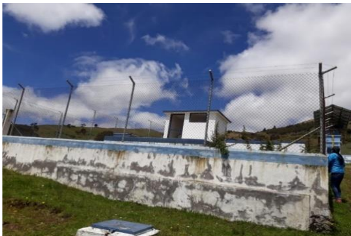
Figura 12. Planta potabilizadora de Chilco
