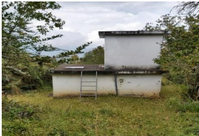
Figura 9. Planta potabilizadora de Zuleta
