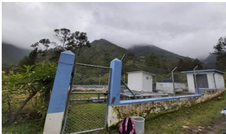
Figura 8. Planta potabilizadora de La Rinconada
