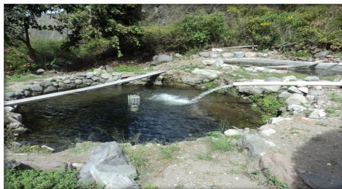
Figura 3. Estanque circular con revestimiento de piedra y concreto Fuente: Truchicultura imbabureña. Cantón Urcuquí. Comunidad Cahuasquí. (2019).
