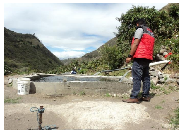
Foto 6. Estanques de hormigón Cahuasquí
