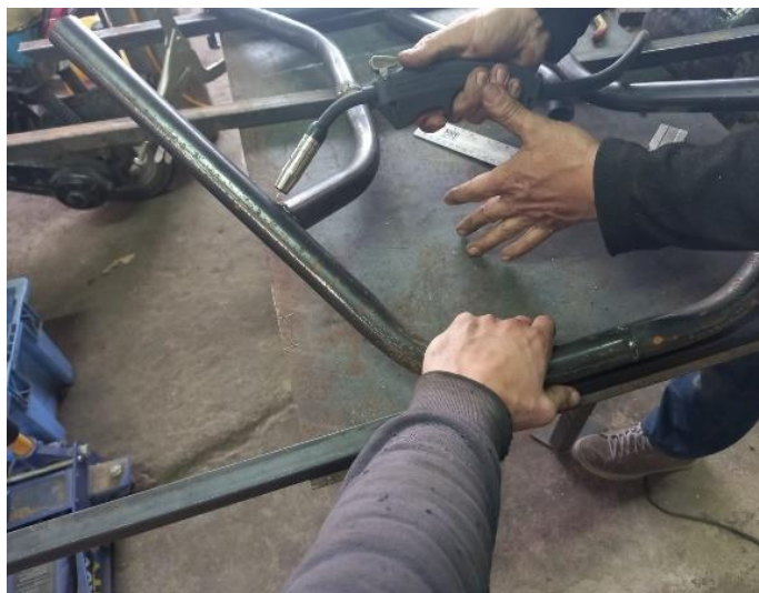
Figura 57 Soldadura de la estructura Fuente Propia
