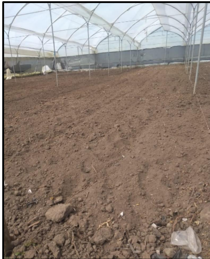
Figura 1 Nivelación del suelo
