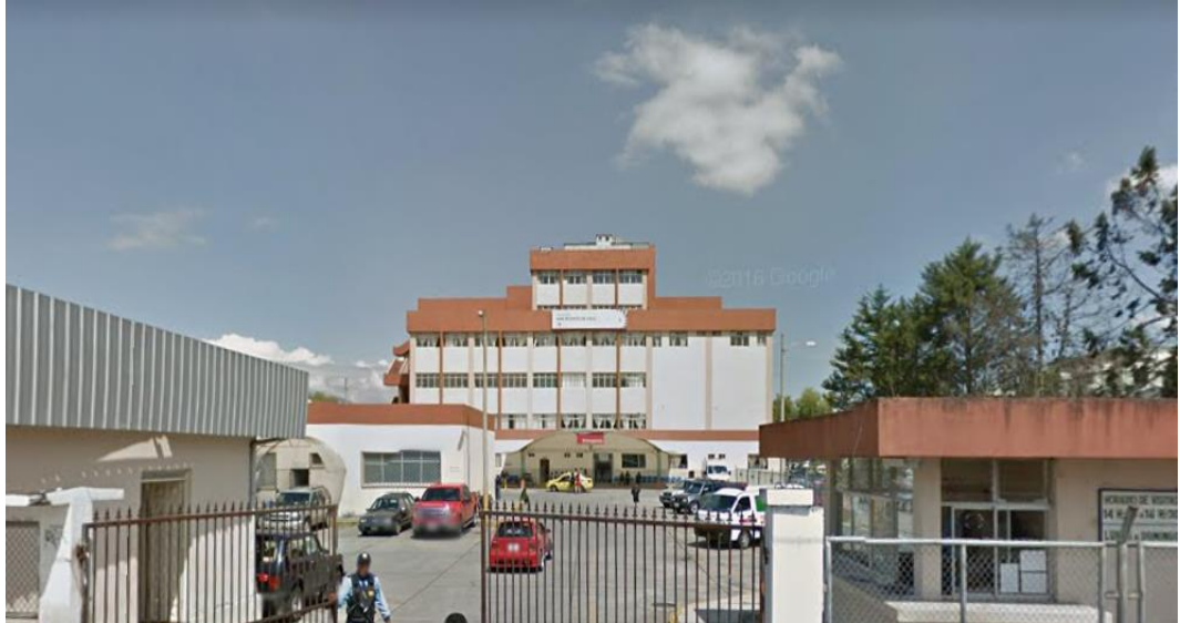
Ilustración 1. Edificio actual del Hospital San Vicente de Paúl
