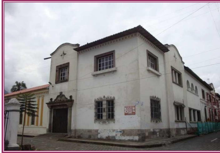
Ilustración 1. Edificio antiguo del Hospital San Vicente de Paúl
