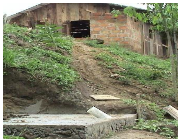
Foto # 6. Piso de la chanchera
