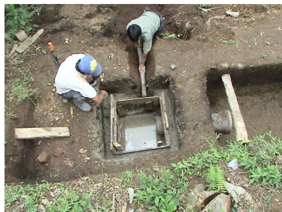
Foto # 4. Fundido de tanques
