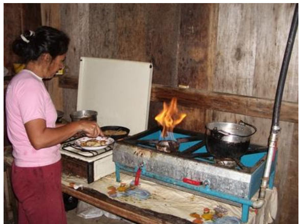
Foto # 18 Cocineta de gas licuado y biogás.
