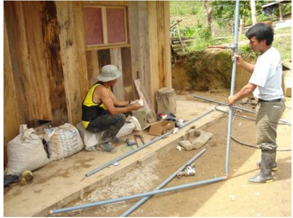
Foto # 14. Armado de la tubería
