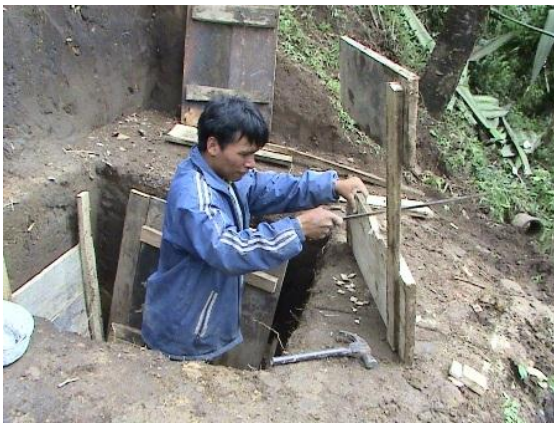
Foto # 3. Encofrado de tanques
