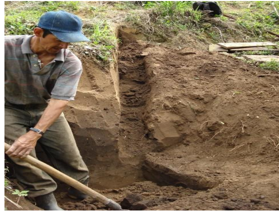
Foto # 2. Exc. para tubería
