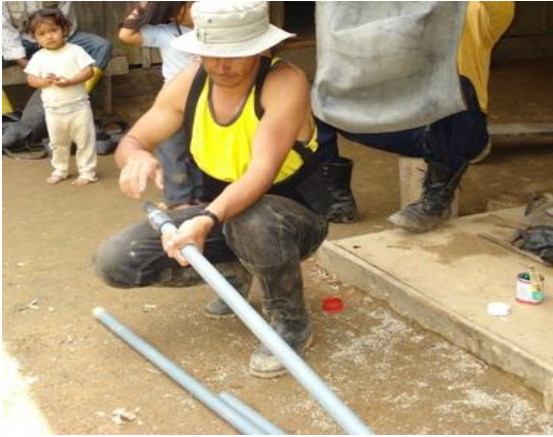
Foto # 13. Pegado de la tubería pvc
