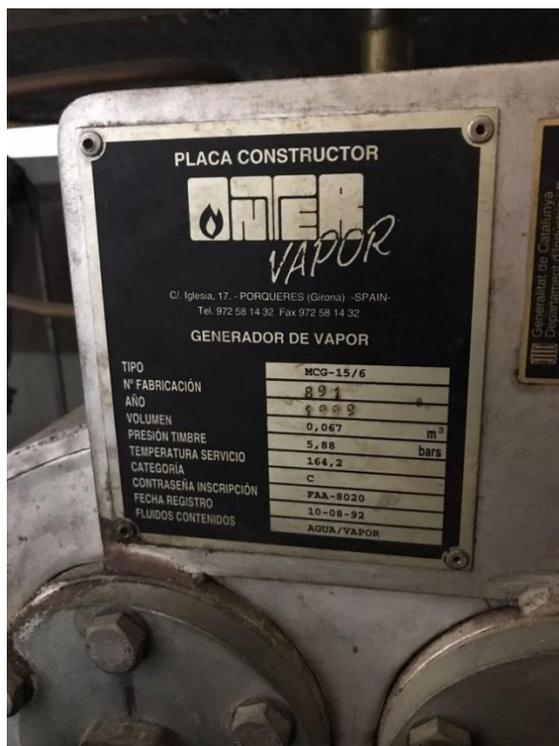
*Figura 14. Datos del fabricante de la vaporizadora.*
