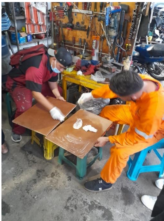
Figura 2.16 Aplicación de cera desmoldante en los tableros
