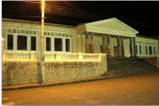
Figura 23. Muro del Colegio San Pablo
