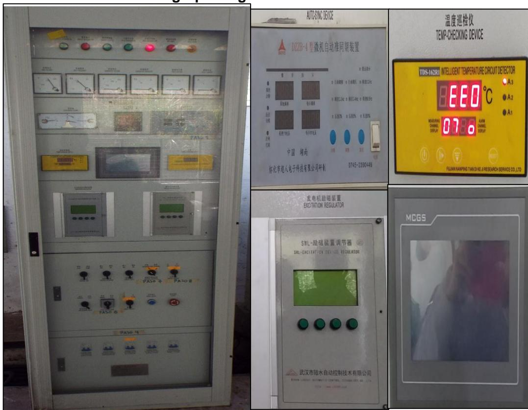
Fig.3.8: tablero de control grupo de generación central hidroeléctrica HidroCarolina
