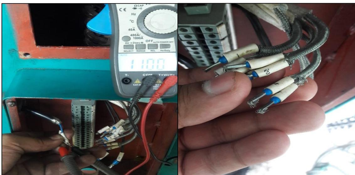
Fig.3.7: Comprobación de Conexionado interno del tablero de control del grupo de generación numero 3 Central Hidroeléctrica HydroCarolina
