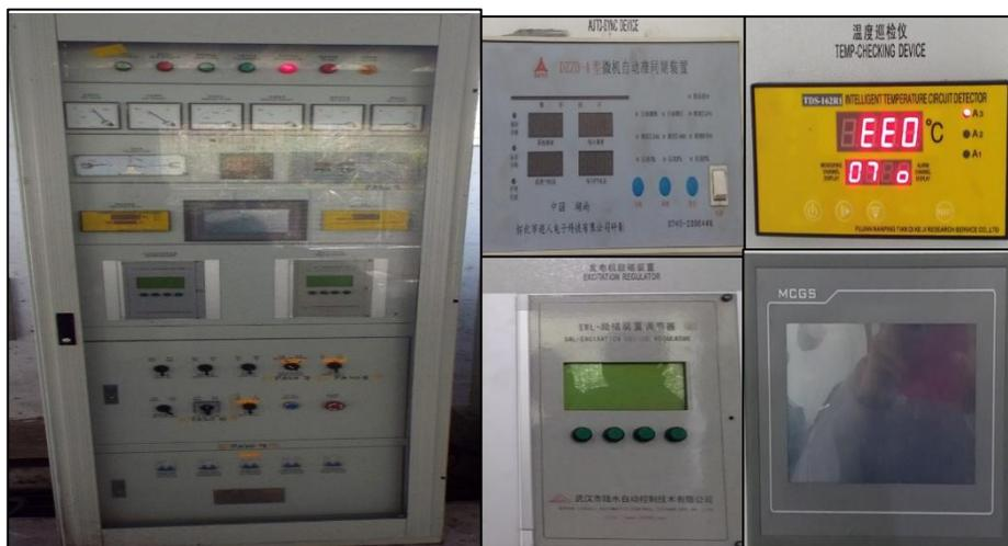
Figura 5 Tablero de control grupo de generación central hidroeléctrica HidroCarolina.
