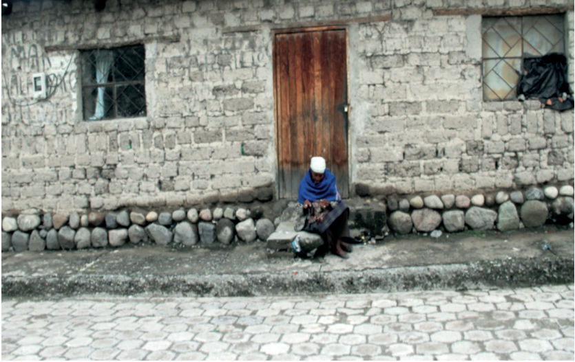
Figura 34. Vivienda de fachada simple sin enlucido, 2017.
