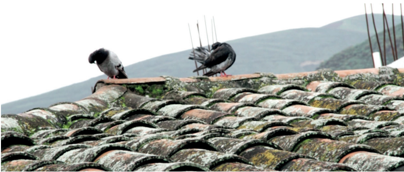
Figura 38. Cubiertas a cuatro vertientes, 2017.
