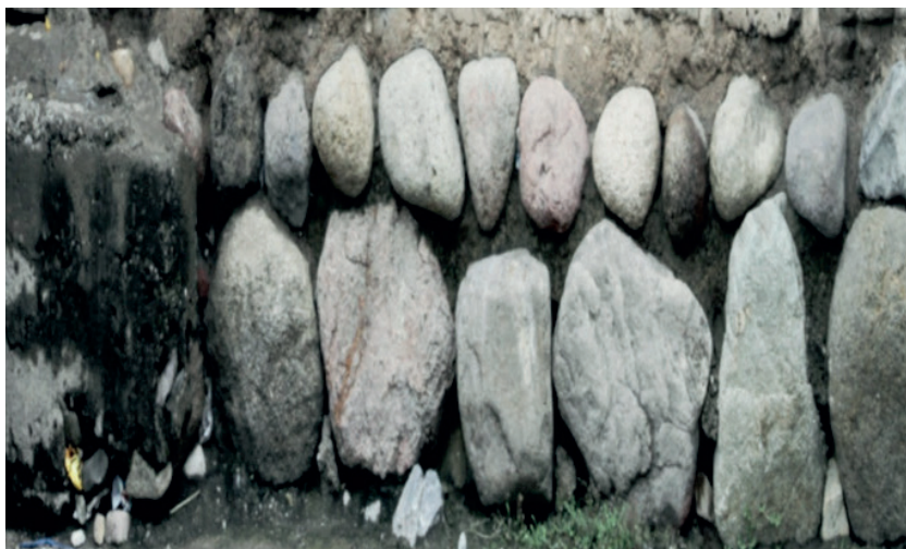
Figura 41. Cimientos de piedra, 2017.
