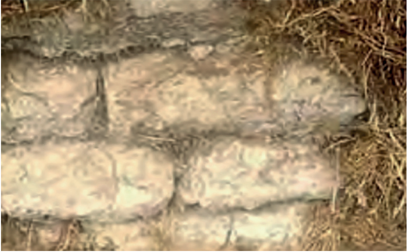
Figura 11. Pared de chamba.
