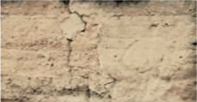
Figura 9. Pared de tapial, Chaltura, 2016
