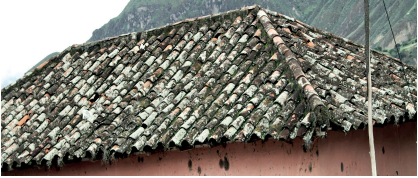
Figura 32. Vivienda vernácula con cubierta a cuatro vertientes, 2017.
