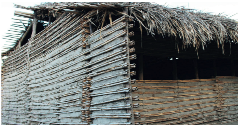
Figura 7. Paredes de bahareque. Valle de Salinas, Museo de la Sal, 2015.
