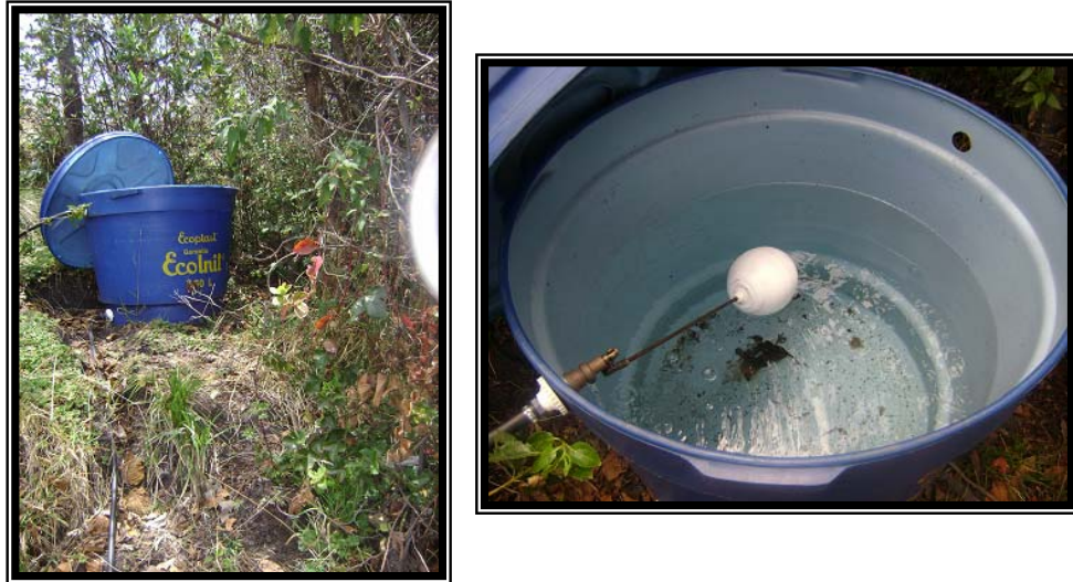
Foto 3.5. Tanque de agua de 250 litros
