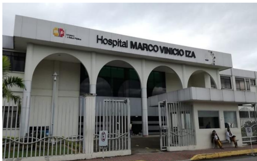
Ilustración 4 Nuevo Hospital Marco Vinicio Iza
