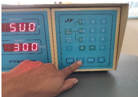
Figura 2.14 Encendido del módulo controlador del banco
