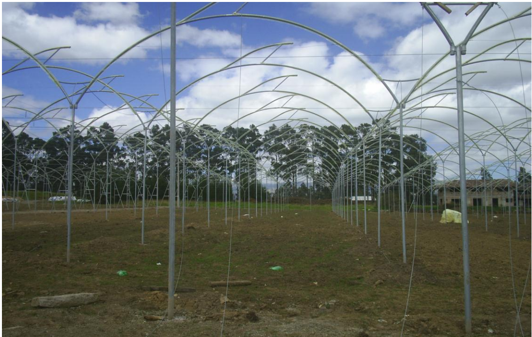
Fotografía 2. Construcción del Invernadero.
