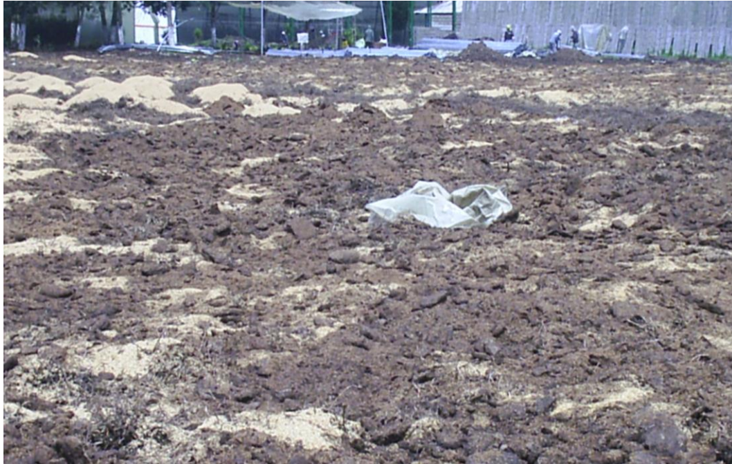
Fotografía 1. Preparación del terreno.
