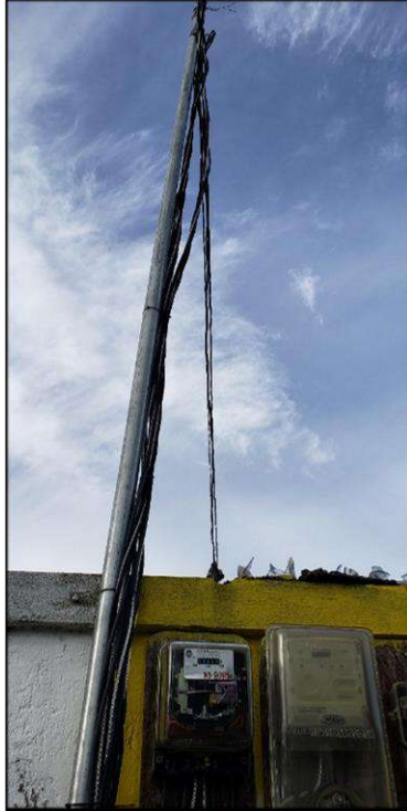
Figura. 22: Acometida doble monofásica trifilar
