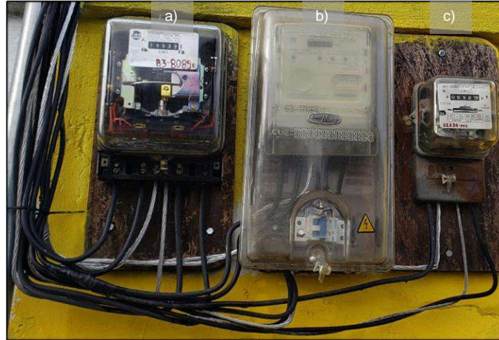
Figura. 23: a) Contador electromecánico. b) Contador electrónico. c) Contador fuera de servicio.
