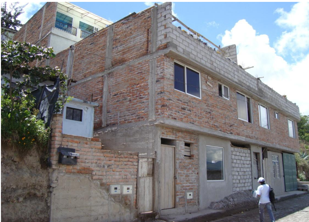
Constructivo convencional: aporcados de hormigón armado, paredes de ladrillo, bloque, entresijos de hormigón armado, cubierta de losa, madera y otros.
