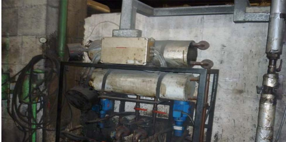
**Figura 2.5 Proceso número 3 de calentamiento de combustible del tren T07**
