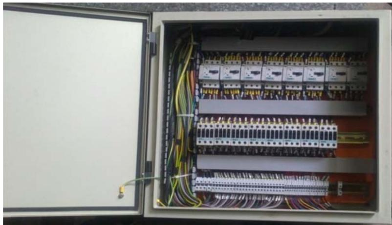
**Figura 3.4 Tablero local del tercer proceso de calentamiento**
