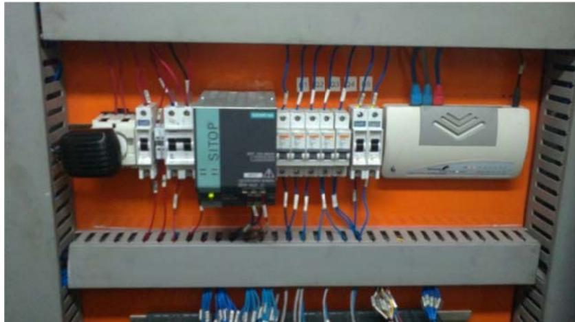
Figura 3.8 Breakers de las alimentaciones de 110 VAC y de 24VDC
