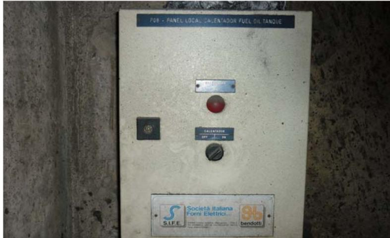
**Figura 2.1** Tablero de control del tanque principal de almacenamiento de bunker del tren T07
