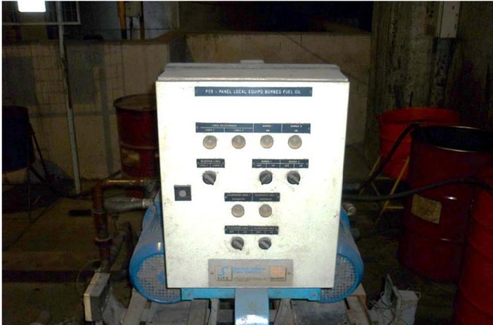
**Figura 2.3** Tablero de control del proceso número 2 de calentamiento de combustible del tren T07
