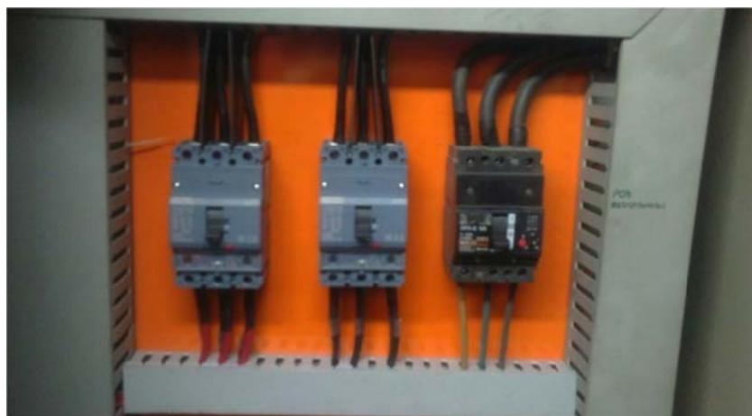
**Figura 3.7** Breakers de las líneas de alimentación de 440VAC
