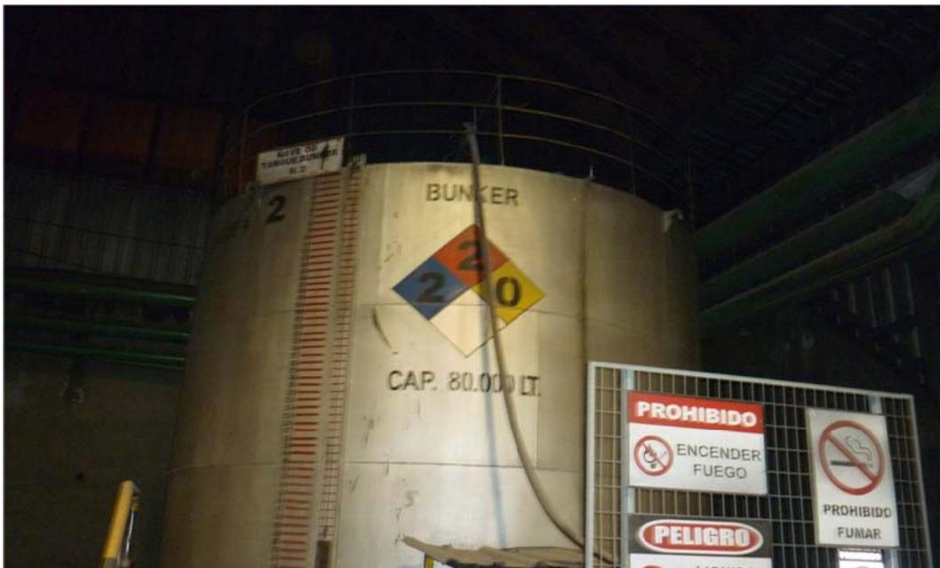
**Figura 2.2** Tanque principal de almacenamiento de bunker del tren T07
