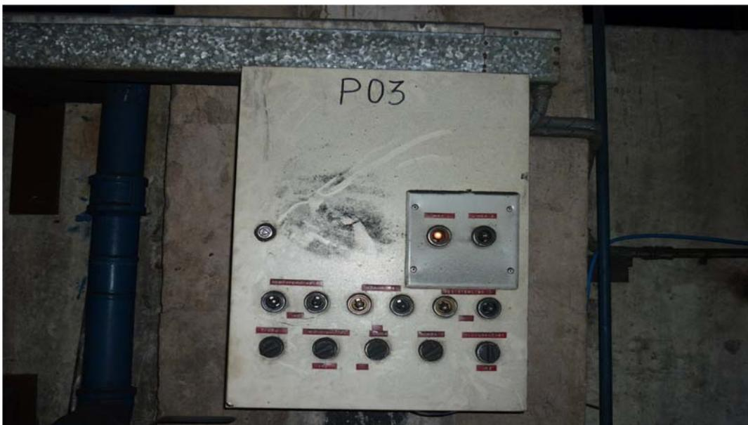
**Figura 2.6 Tablero de control del proceso número 3 de calentamiento de combustible del tren T07**
