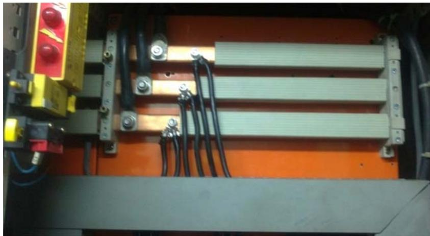
**Figura 3.6** Líneas de alimentación de 440 VAC Cabina Horno T07
