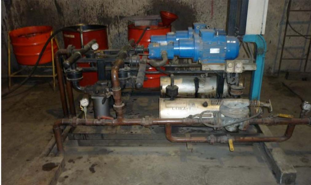
**Figura 2.4 Proceso número 2 de calentamiento de combustible del tren T07**
