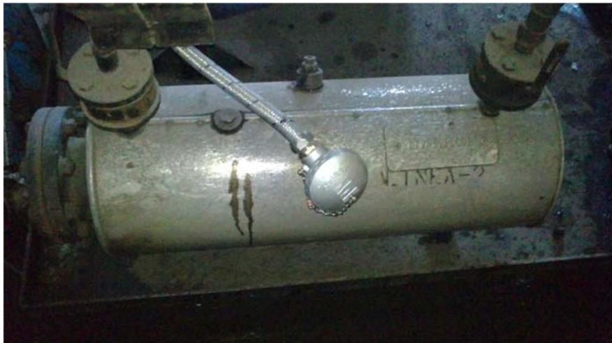
**Figura 3.12 Cableado de sensores del sistema de control de calentamiento de combustible del T07**
