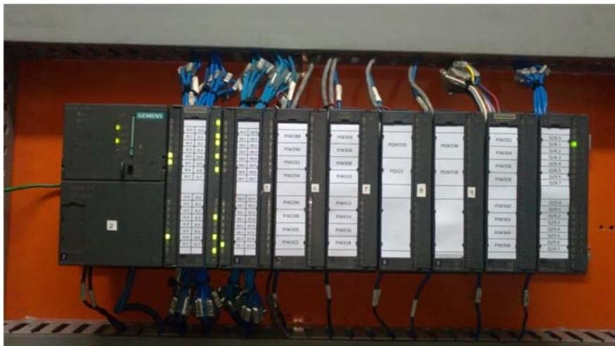
Figura 3.10 Instalación de módulos en el PLC
