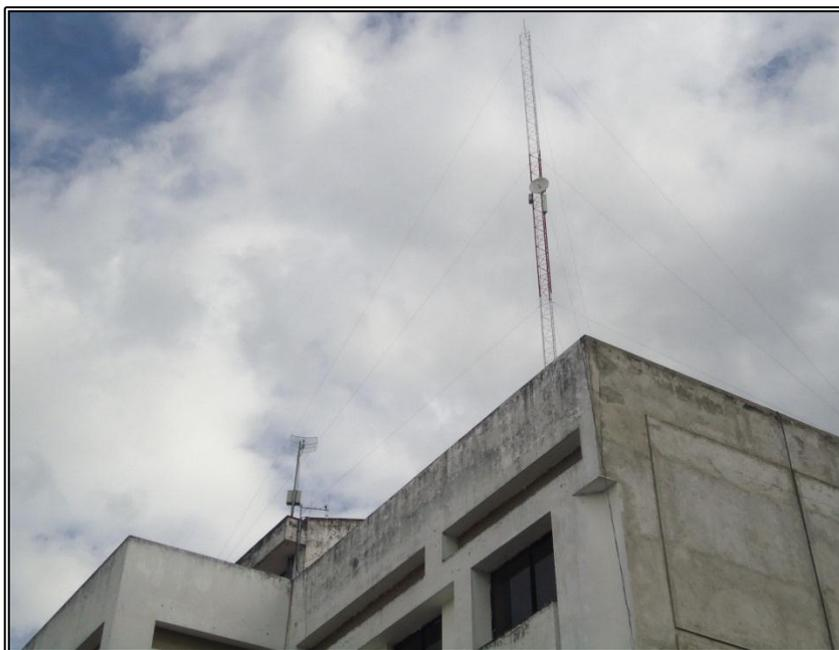
Figura 48. En la parte derecha el Mástil de 4 metros y el mástil de 2 metros, y en el lado izquierdo la Torre metálica de 48 metros de altura
