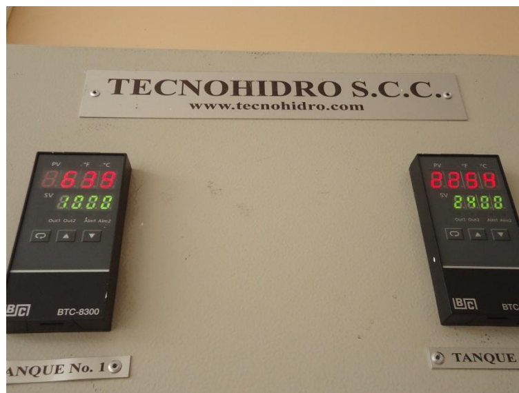
Figura 3. Display BTC800, ubicados en el tablero de la subestación Azaya.
