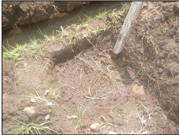
Fotografía 14. Agua recolectada en la zanja y hoyo encharcado, Yahuarcocha, UTN, 2006
