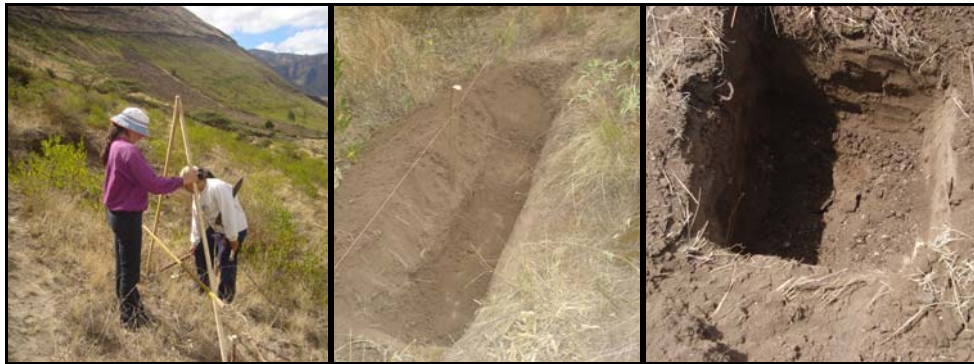
Fotografía 6. Señalamiento y apertura de zanjas de infiltración y hoyos. Yahuarcocha, UTN. 2006
