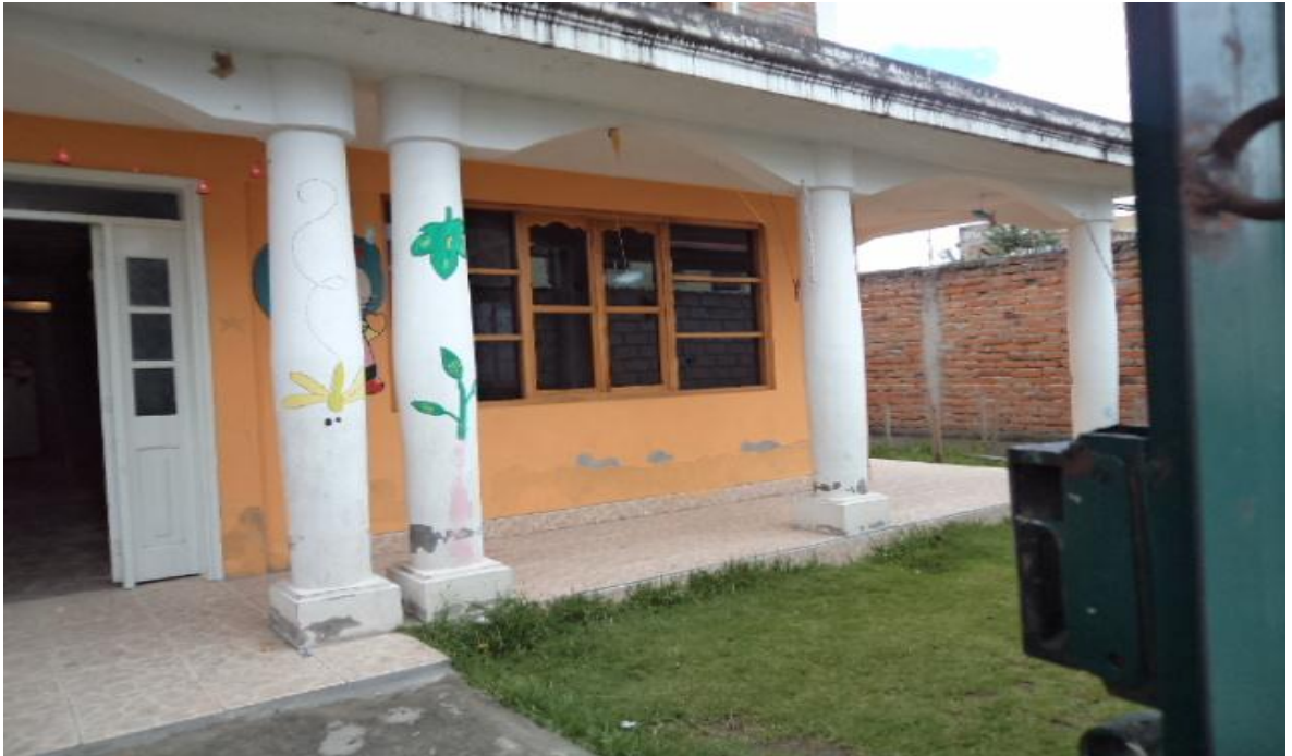
Infraestructura del CI "Pequeños Traviesos" en la ciudad de Otavalo
