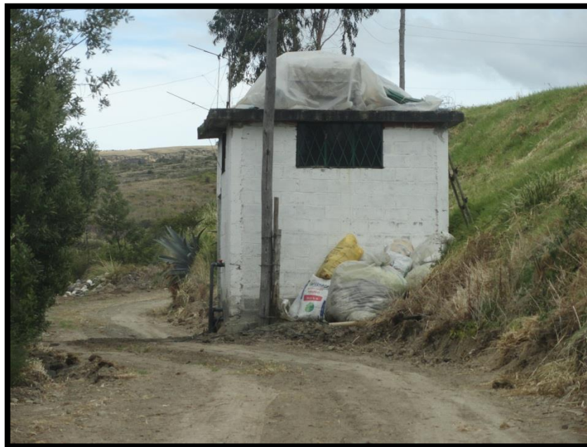
Fotografía 2. Cuarto de máquinas
