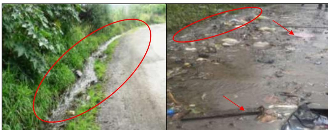
**Figura 4-9: Uso inadecuado de las cunetas.**
