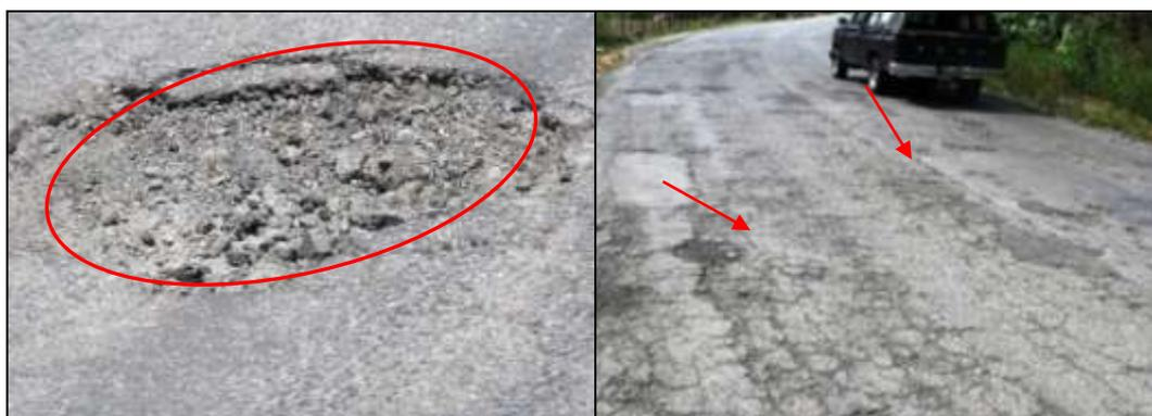
**Figura 4-13: Carpeta asfáltica fragmentada y baches**
