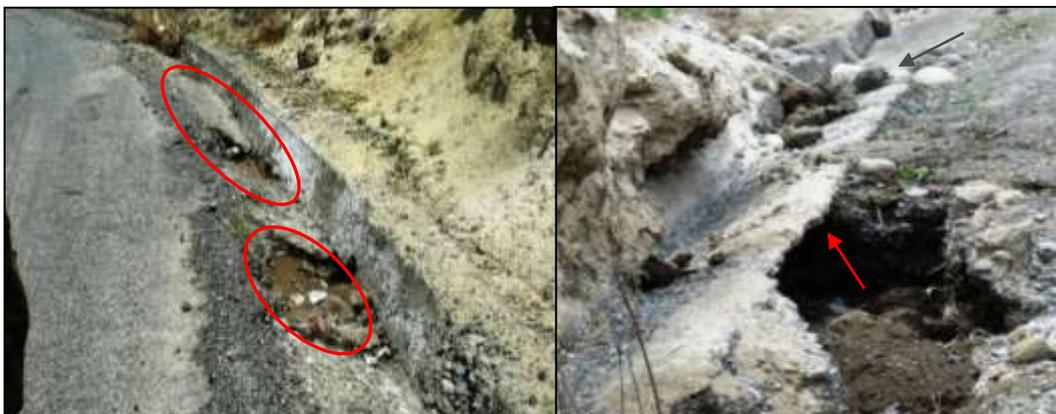
**Figura 4-10: Mal estado de cunetas.**
