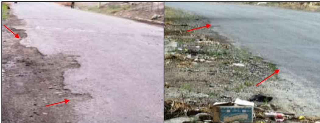
**Figura 4-15: Escaso espesor de carpeta asfáltica.**
