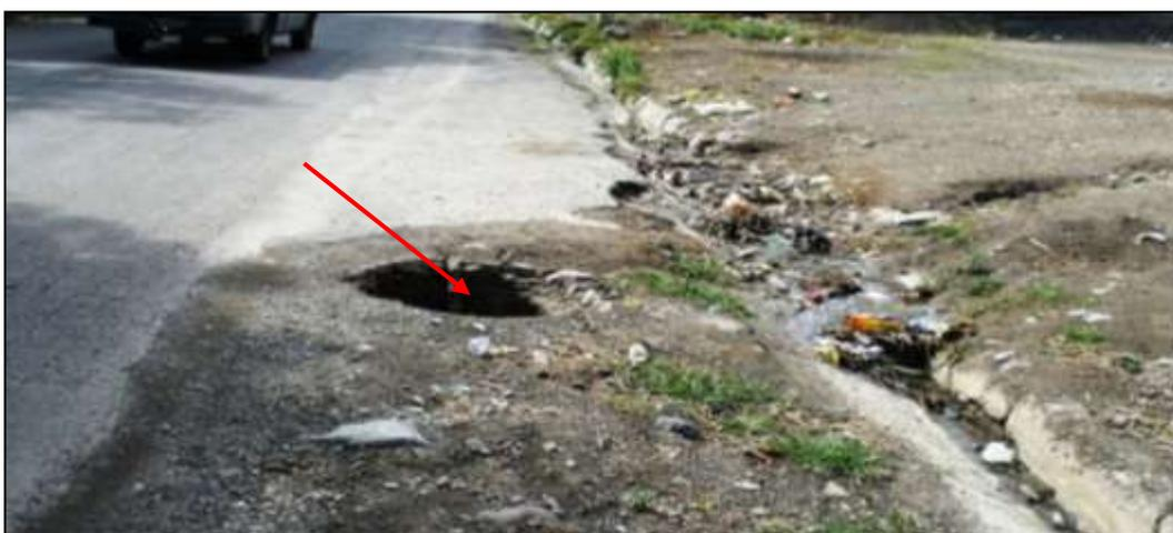
**Figura 4-7: Obstrucción del alcantarillado.**
